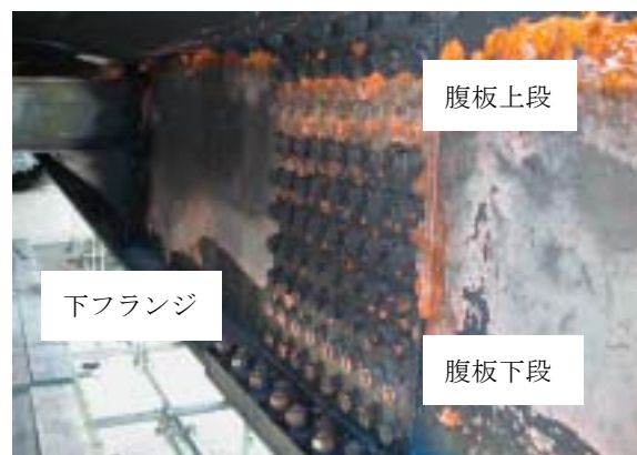
写真-2 主桁添接部 軸力測定箇所
