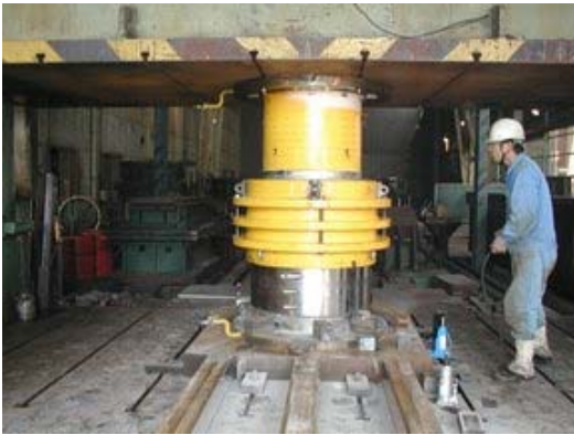
写真-1 ブロック 2000t プレス製作状況
