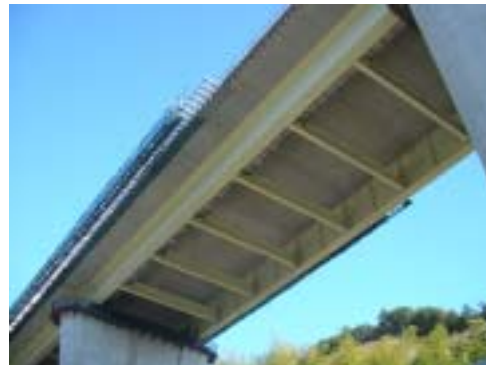
写真－1 藁科川橋全景
