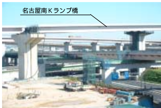
写真 - 1 国道を跨ぐKランプ橋
