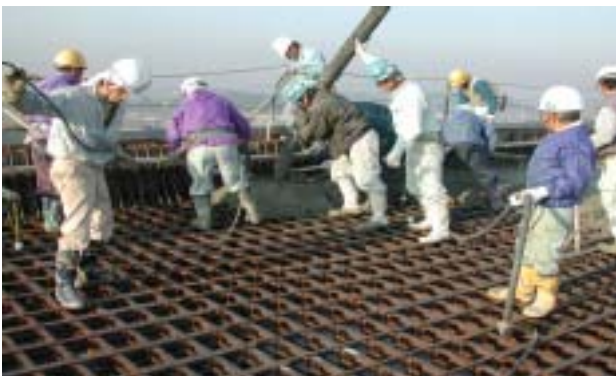
写真-2 実橋におけるコンクリート打ち込み状況
