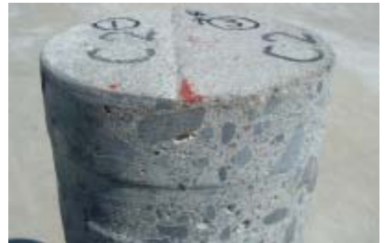
写真－2 打ち継ぎ目のコア抜き
