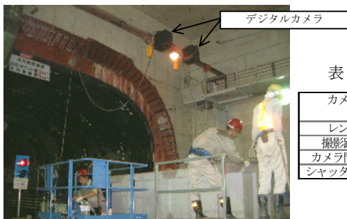
図5 ブリ鋼車計測状況
