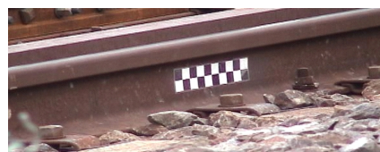
図-2 軌道外側面のターゲット
