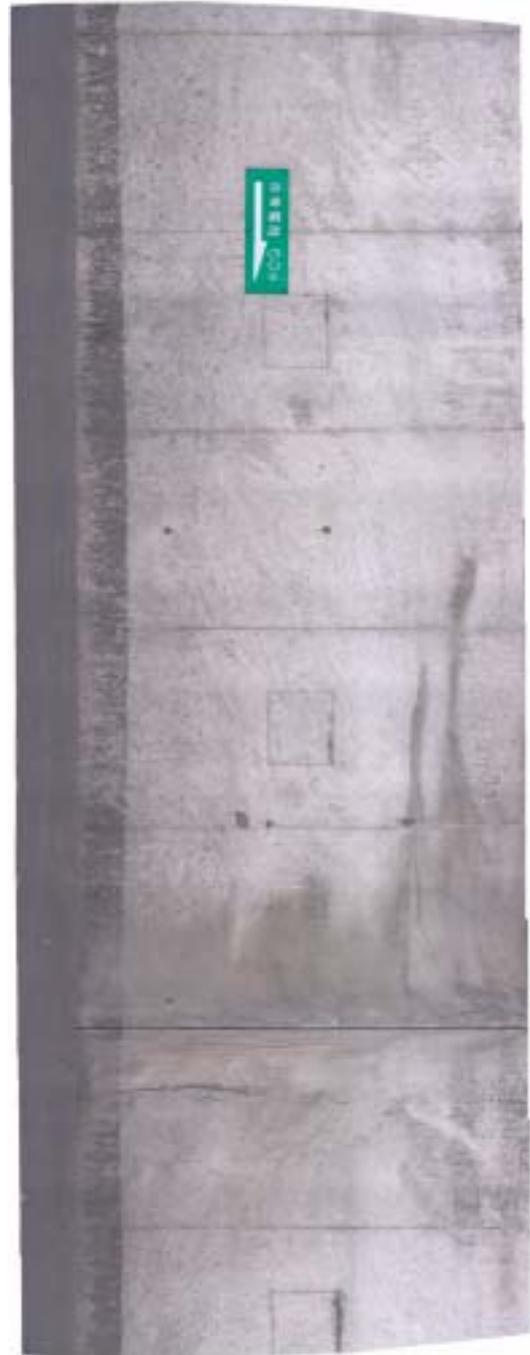
図7 トンネル覆工面合成画像
