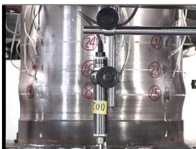
図 3 基部の局部座屈の様子
