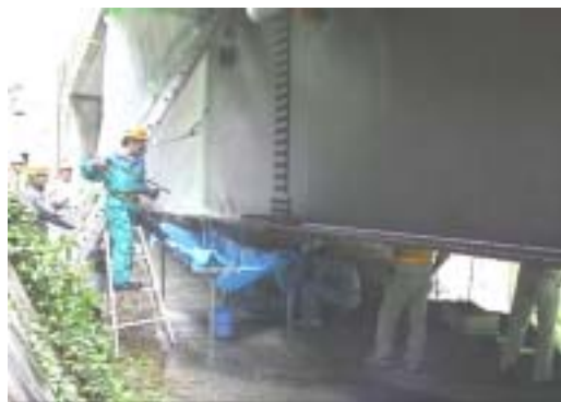
写真-1 水洗い実施状況（浦の谷川橋）
