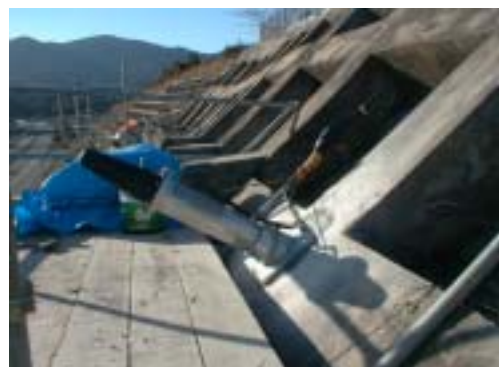
写真-3 設置完了状況
