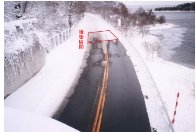
写真-1 融雪状況(平成15年1月25日)
