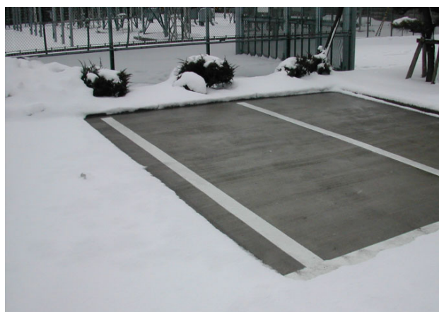
写真-1 融雪状況 (平成15年1月16日7:00)
