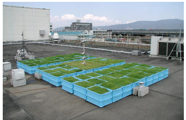
写真-1 屋上緑化区画
