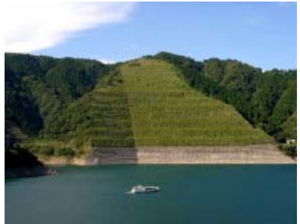
写真 1 宮ヶ瀬ダム原石山法面(2000年9月)
