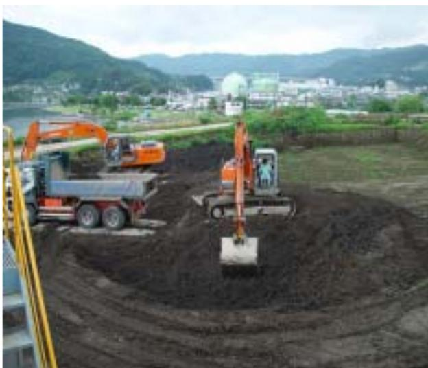
写真 3 諏訪湖浚渫土の固化改良工事
