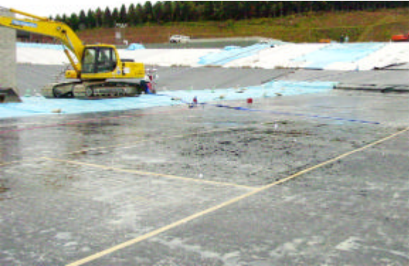
写真-3 降雨中のHDPE/GCL 状況
