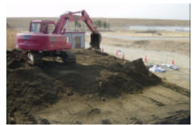
図-4 盛土の構築
