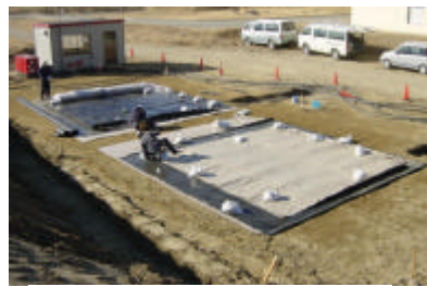
図-3 遮水シート工の設置
