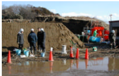
図-5 遮水シート工への注入
