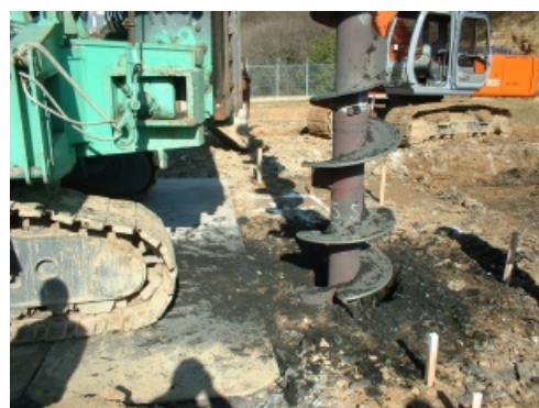
写真-2 掘削、圧縮状況
