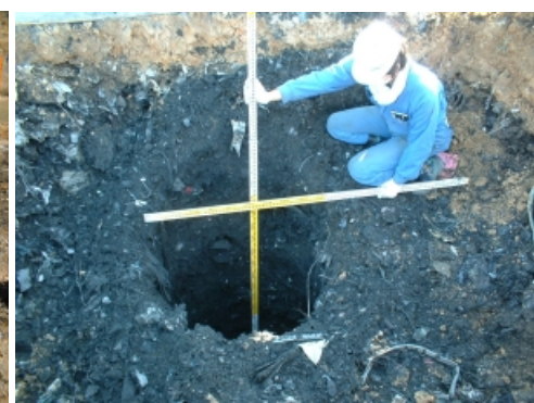
写真-3 形成された掘削孔
