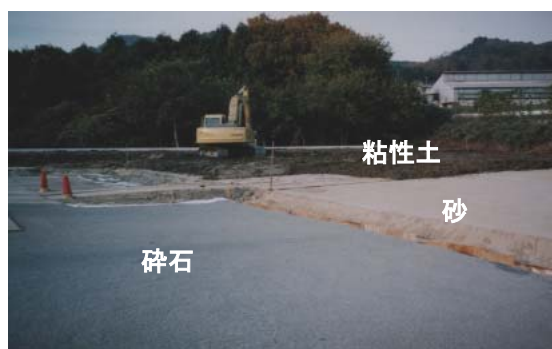
写真－１ 施工状況
