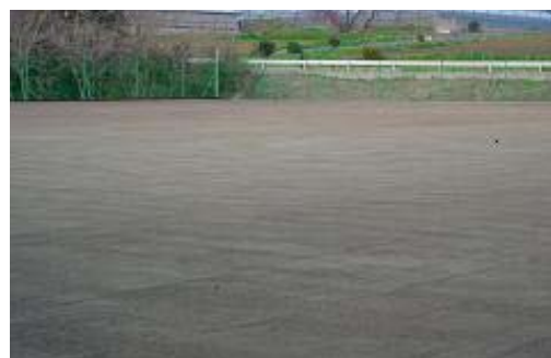
写真－２ 完成後の状況
