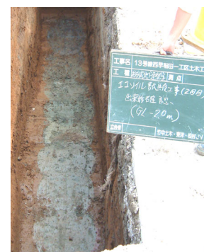
写真－１ 壁体頭部
