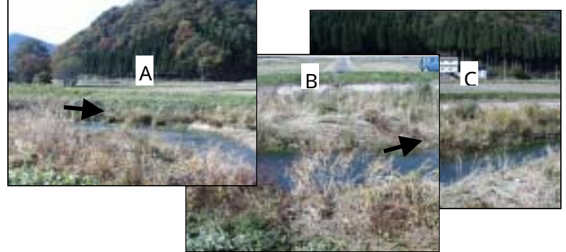
図 3 流路の調査区間全景 平成 14 年 11 月 L=50m（右岸より）
