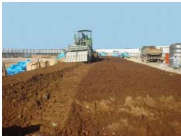
写真 - 1 スタビライザーによる中和剤の混合
