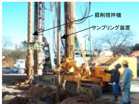
写真－3 施工状況
