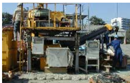
図-2 システムフローおよび装置写真
