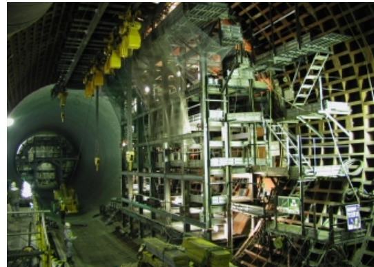
写真 - 2 ひずみ拘束鋼材全景
