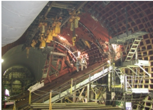
写真 - 1 補強鋼版（上段）据付状況
