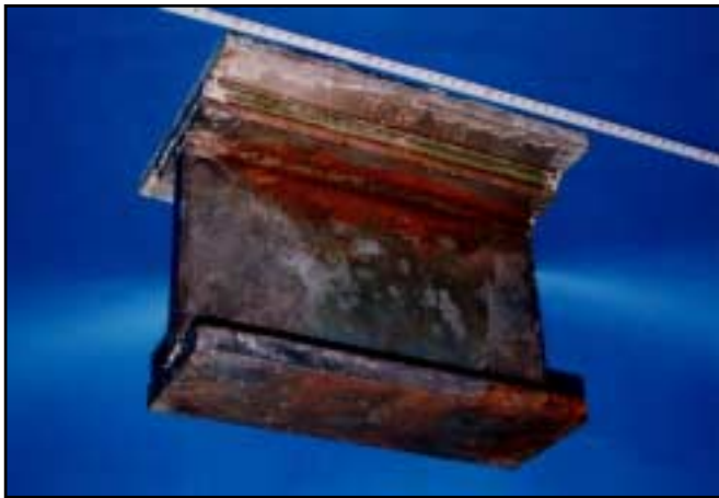
写真-1(a) 試験片Aの腐食状況（鋼材部）
