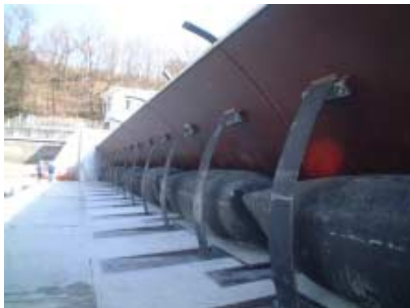
写真 - 2 下流面の状況（無水、平成15年2月）
