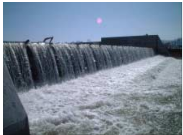
写真 - 3 通水状況（平成15年3月）
