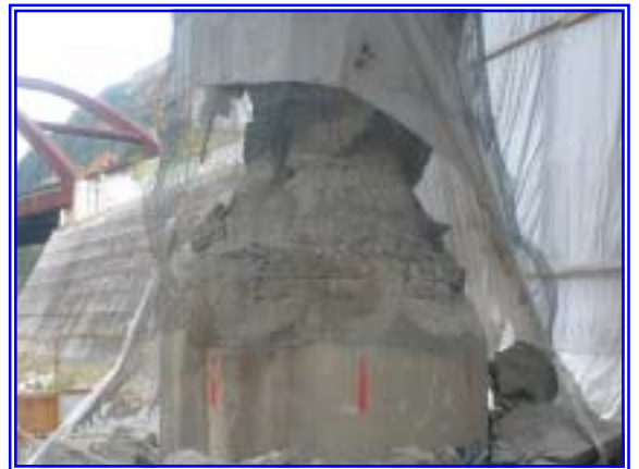
写真－2 発破後の歩道橋脚
