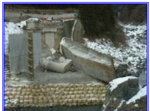
写真-3 発破後倒壊状況
