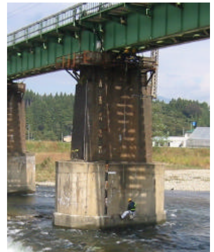
写真-1 高所作業状況
