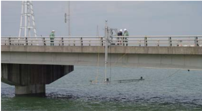
図-5 撮影試験実施状況
