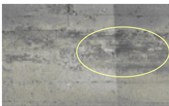
写真-5 補修箇所状況
