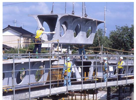
写真-4 センターブロックの架設
