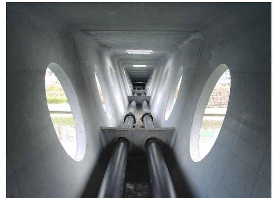
写真-3 桁内の外ケーブル配置状況
