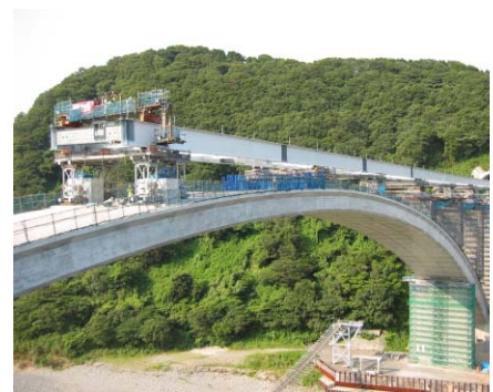
写真-1 鋼桁送り出し架設状況
