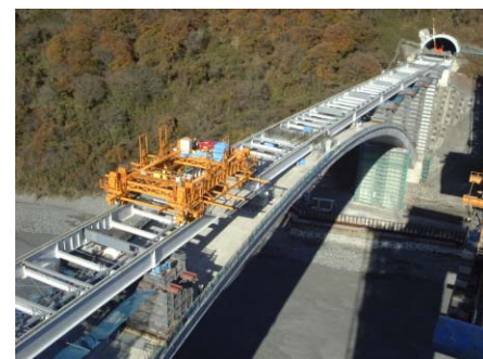
写真-2 PC床版架設状況
