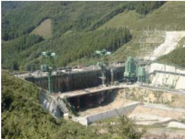
写真－1 上流から見た施工状況
