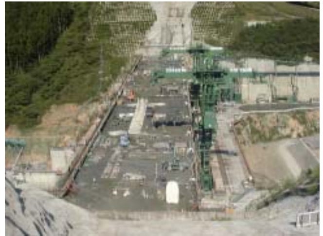
写真－2 上流から見た施工状況
