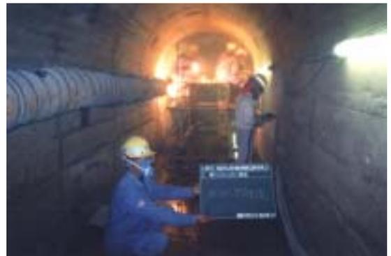
写真-1 ジェットタガネによる人力作業の一例
