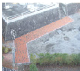
写真-3 現地設置状況1
