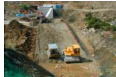
写真-5 CSG 施工状況
