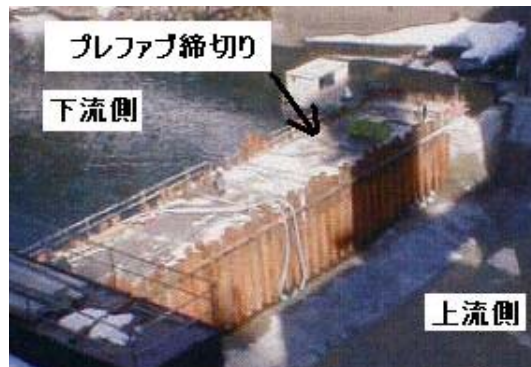
写真-1 施工完了状況
