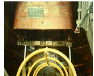
写真2 推進状況（立坑上から）
