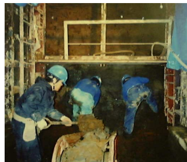
写真1 羽口部人力掘削（坑口から）
