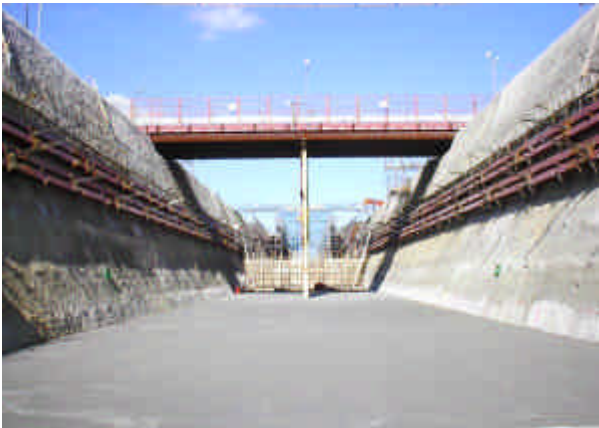
写真 - 1 掘削完了状況
