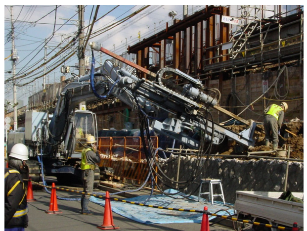
写真-2 \pi イッシュアンカー施工状況
