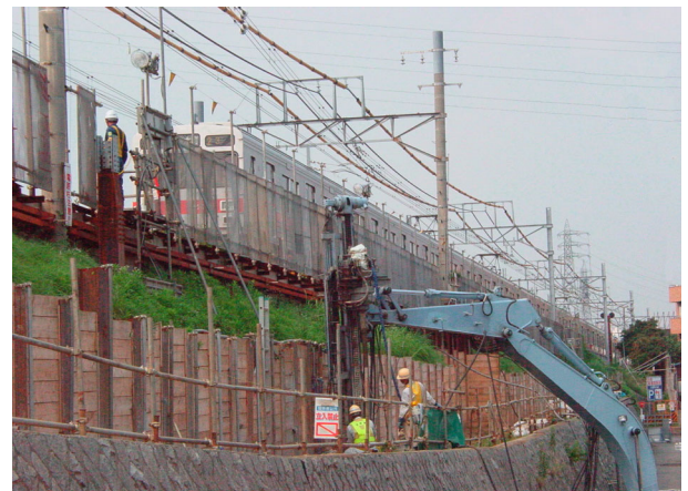
写真-1 鉛直抑止杭施工状況
