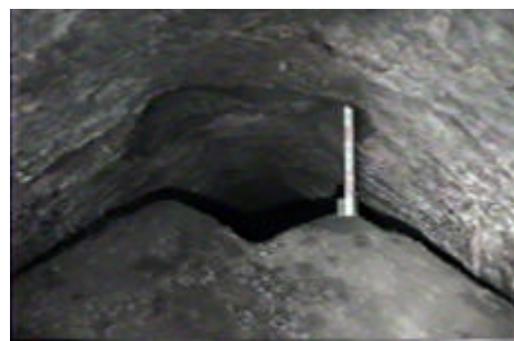
写真-3 中詰碎石投入後の空洞内の状況
