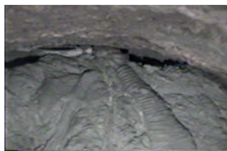
写真-4 可塑状モルタルの打設充填状況
