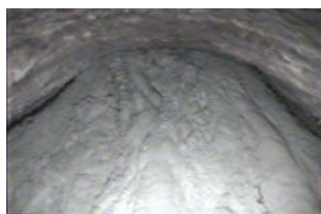
写真-5 完成した離隔壁
