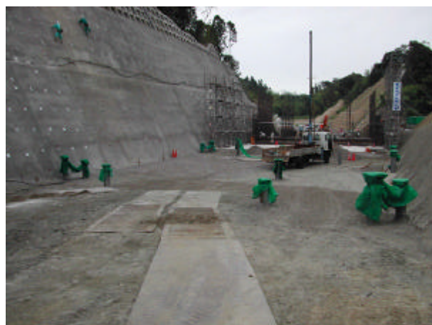
写真-1 現場の状況
