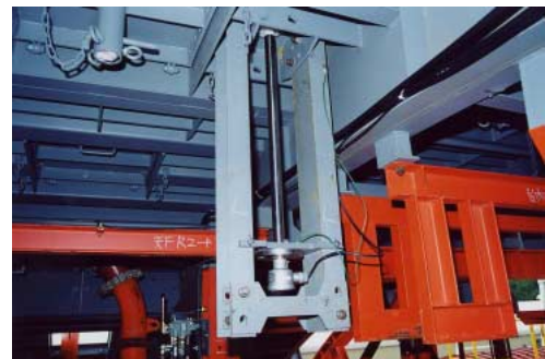
写真-3 コンクリート充填感知センサー
