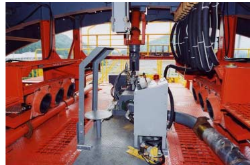
写真-2 エレファントノズル
