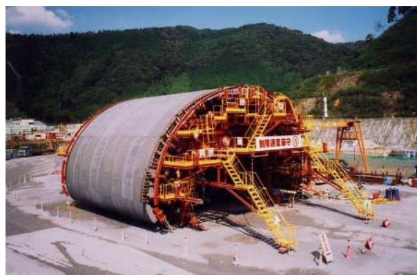
写真-1 セントル全景
