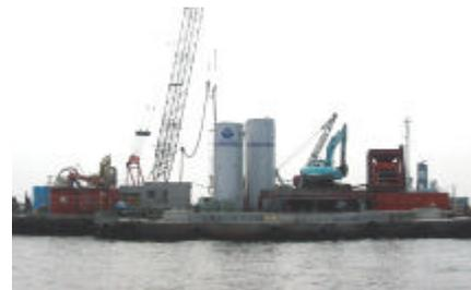
写真-2 遮水材製造プラント全景
