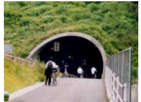
写真-1 賤機山トンネル
