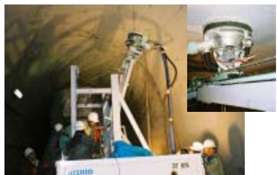
写真-2 飛散防止カップおよび吸引装置
