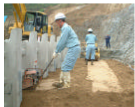
写真 - 4 改良土の転圧状況
