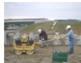
写真 - 4 改良土の転圧状況
