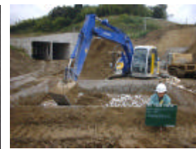
写真 - 3 バックホウによる改良土の攪拌混合状況
