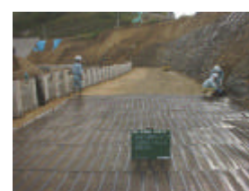
写真 - 6 ジオグリッド敷設状況
