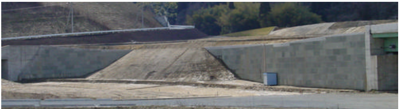
写真 - 1 完成状況
