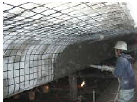
写真 - 3 仕上げ層吹き付け状況
