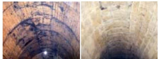
図-6 グラウト施工前（左）後（右）の比較
